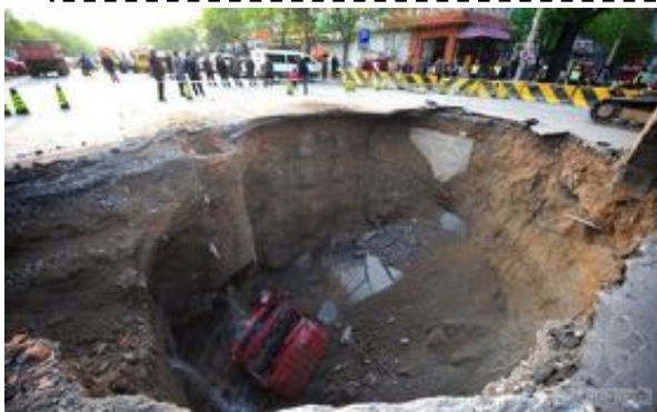
管道泄漏导致地面塌陷
