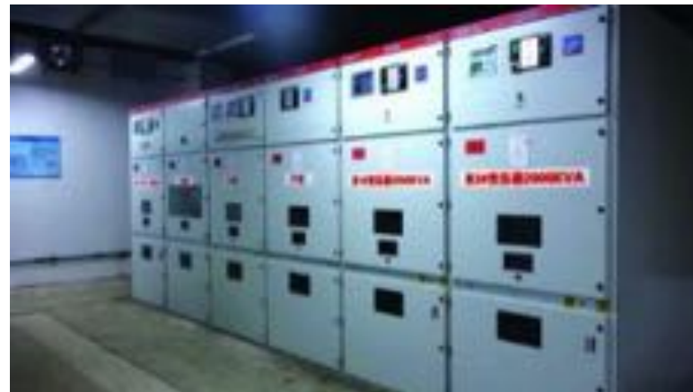
数据中心高低压配电系统
